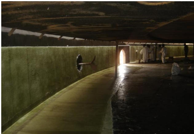
Os dois tanques foram revestidos internamente com resina vinil éster. Foto cedida por Olavo Barbour.
