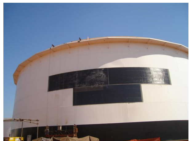
A reabilitação estrutural das chapas corroídas foi feita por fora, com fibras de carbono e resina vinil éster. Foto cedida pela Petrobras.
