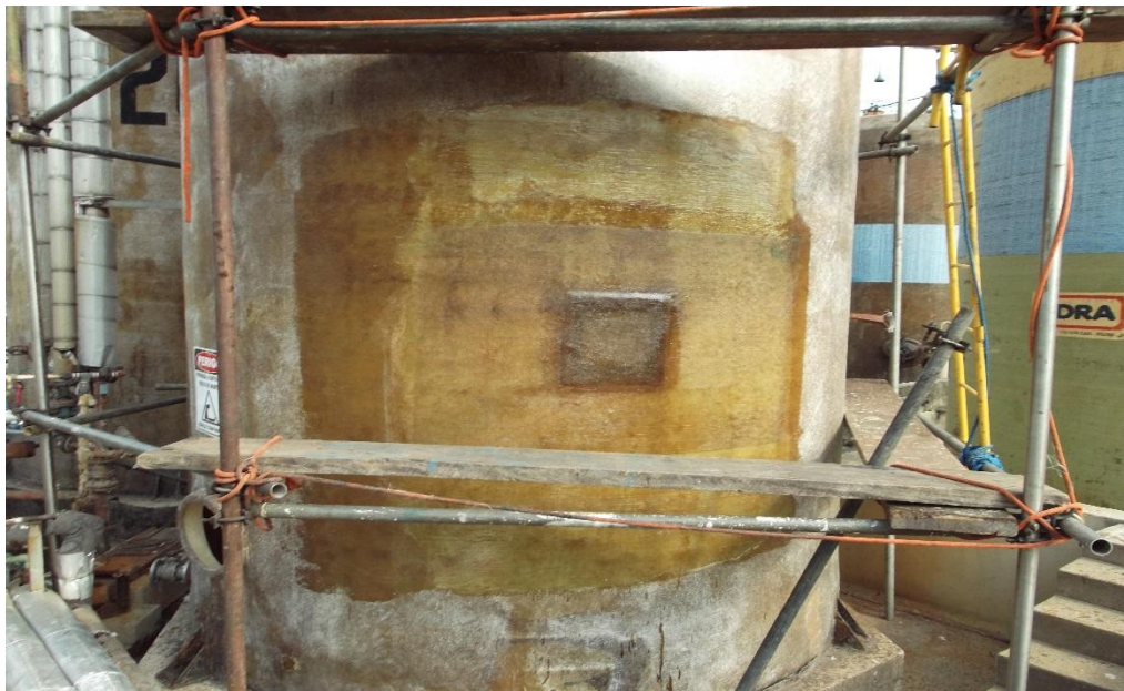
Molde temporário colocado sobre a janela. Este molde serve de apoio para laminar o reparo, sendo removido depois de feito o trabalho.
