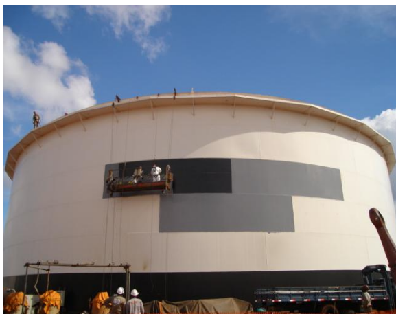
A reabilitação estrutural das chapas corroídas foi feita por fora, com fibras de carbono e resina vinil éster. Foto cedida pela Petrobras.
