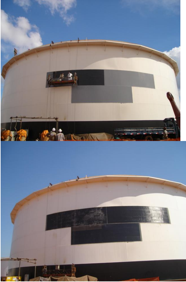
A reabilitação estrutural das chapas corroídas foi feita por fora, com fibras de carbono e resina vinil éster. Foto cedida pela Petrobras.
