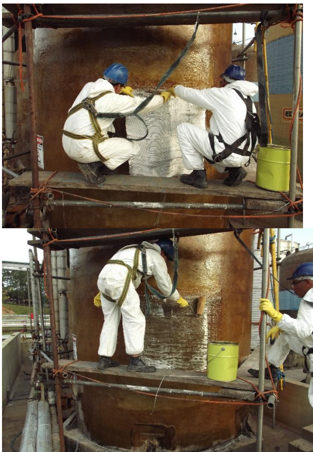
O reparo é laminado externamente sobre o molde. As lâminas maiores são colocadas por baixo.
