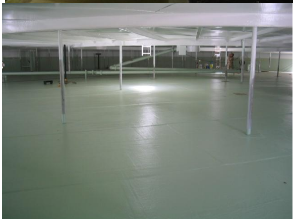
Os dois tanques foram revestidos internamente com resina vinil éster. Foto cedida por Olavo Barbour.
