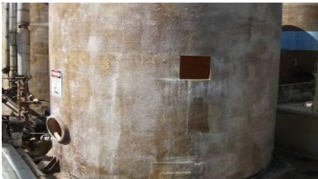
Figura 3 Janela de onde foi extraída a placa para fazer o teste de aderência.
