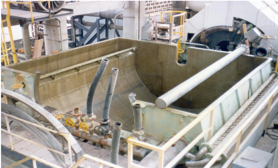
Revestimento de tinas de aço em fábrica de celulose. Laminado feito com camada base, duas mantas M450, véu de superfície e topcoat parafinado. Foto cedida pela Beta Compósitos.
