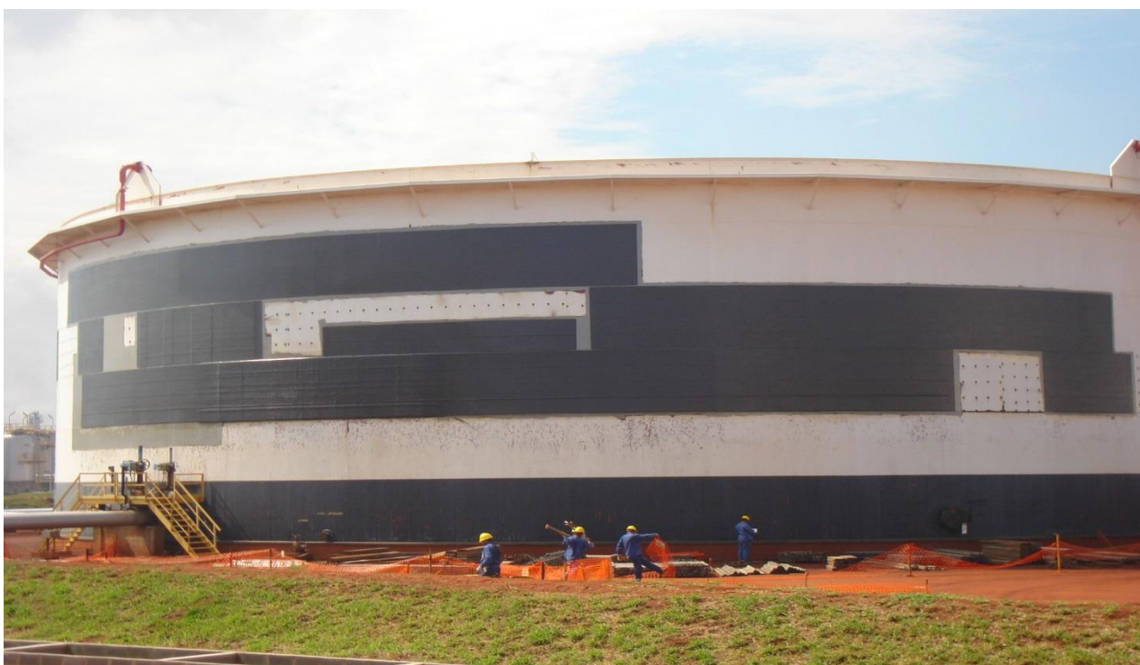
Apenas os locais corroídos foram reabilitados. A espessura do reforço varia conforme a necessidade. Foto cedida pela Petrobras.
