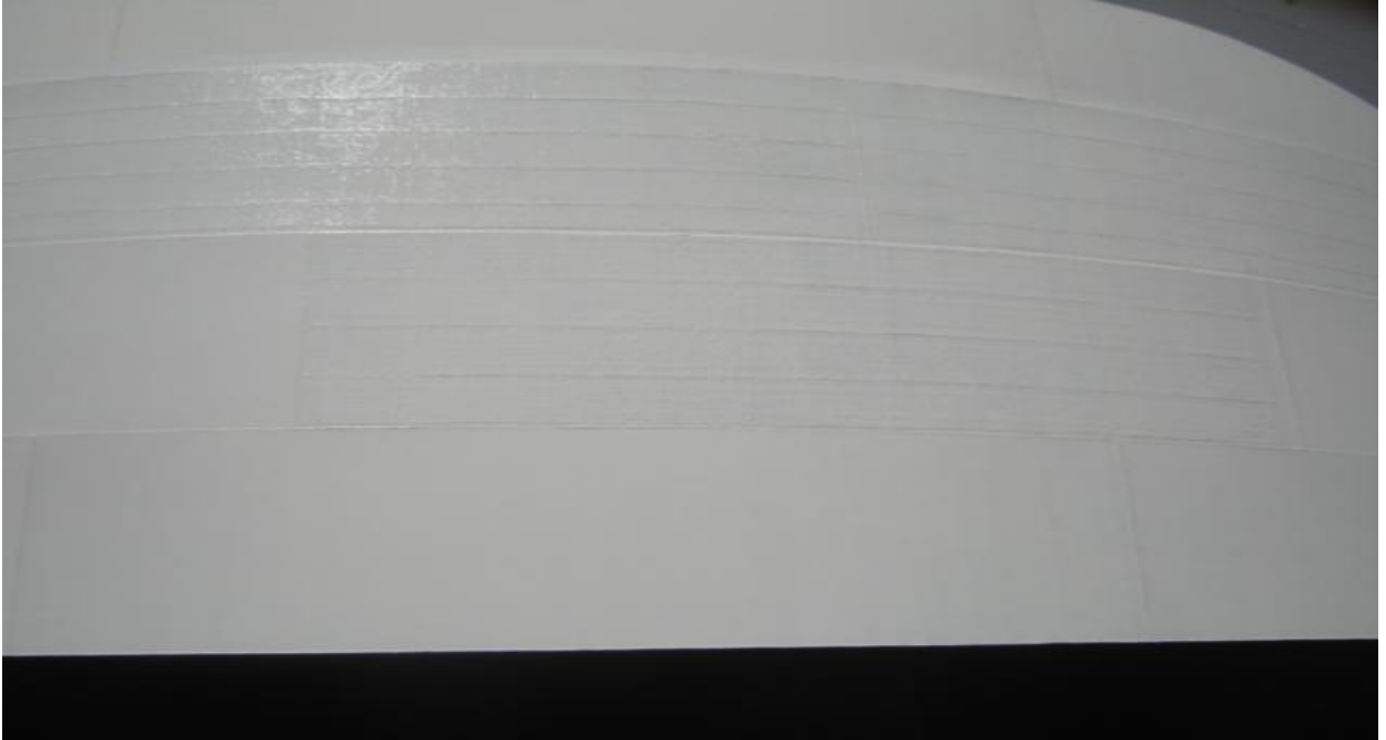
Depois da reabilitação os tanques foram pintados. O ressaltado das lâminas de reparo é quase invisível.
