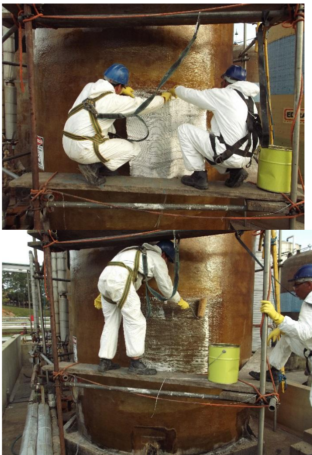
O reparo é laminado externamente sobre o molde. As lâminas maiores são colocadas por baixo.
