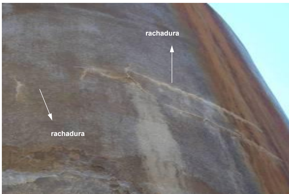
Figura.2 Mostra rachaduras horizontais e verticais no costado. As rachaduras são passantes, isto é, atravessam a espessura do costado.
