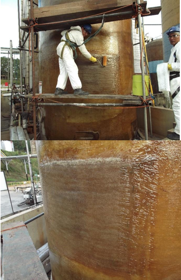
O reparo pronto. A laminação é feita aplicando uma lâmina de cada vez.
