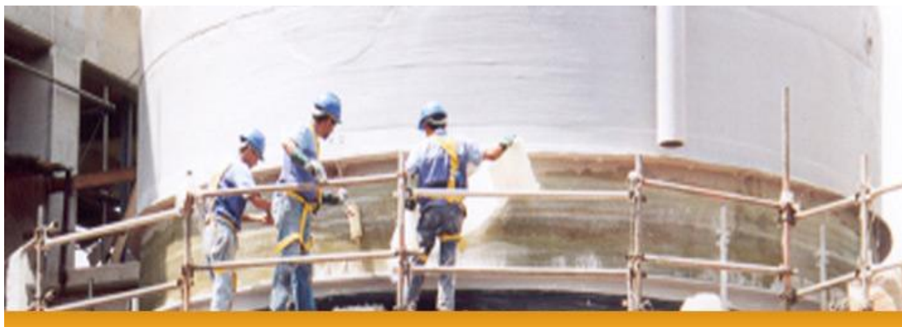
Laminação de emendas no campo. Foto cedida pela Tecniplás.
