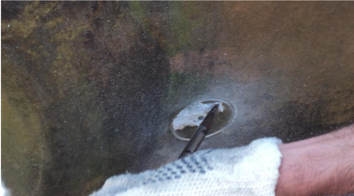
A entalhadeira remove o material cortado pela broca de copo. A remoção das partes soltas é feita com alicate. Foto cedida pela Jatfibra.
